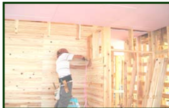
10月1日 内装工事進行中
