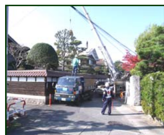
クレーンを使った瓦撤去作業#
